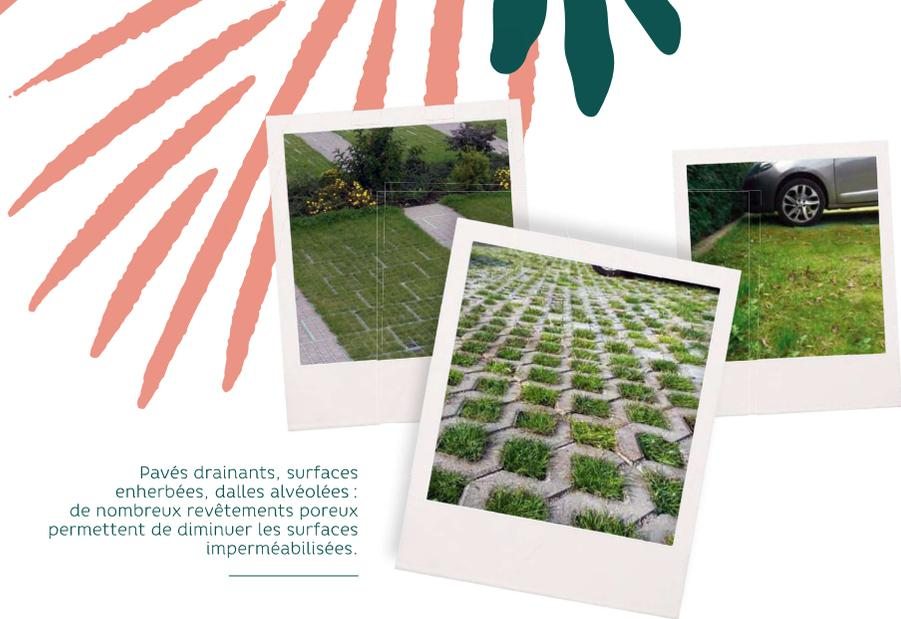
Pavés drainants, surfaces enherbées, dalles alvéolées : de nombreux revêtements poreux permettent de diminuer les surfaces imperméabilisées.
